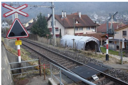
Un passage suffisamment utilisé pour justifier son maintien, estiment les autorités
