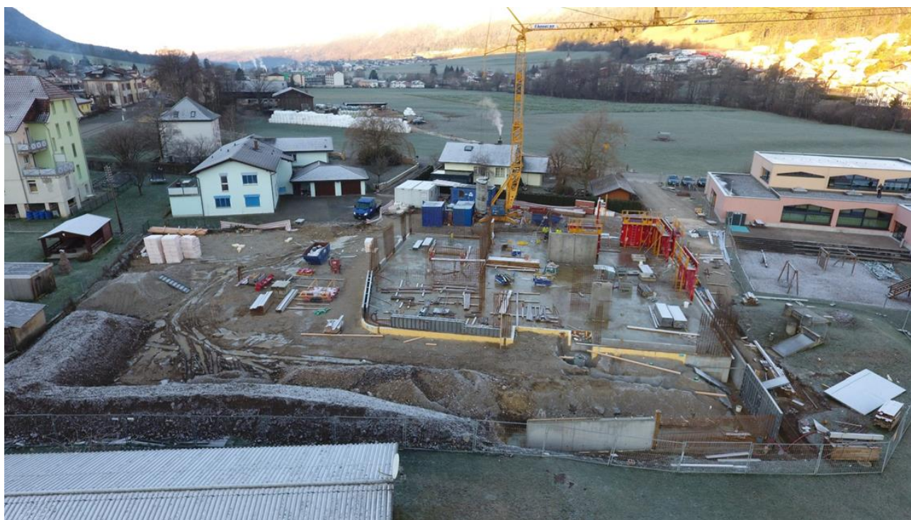
L'état actuel d'un chantier qui est en avance sur son calendrier
